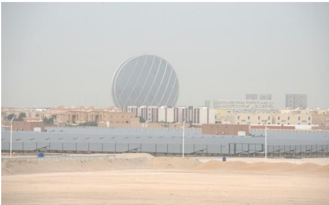
Рис. 5. Солнечная электростанция города Масдар
